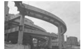
江戸橋ジャンクション(架設中)
