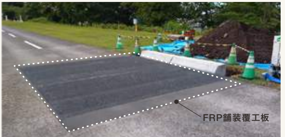
走行試験時設置状況
