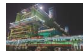
中国自動車道 石橋跨線橋(下り線)
