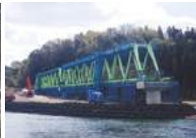
球磨川第四橋梁(TT3/TT4)の架設状況
