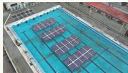
浮体式ペロブスカイト太陽電池
