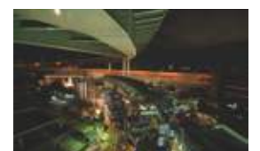
海老江工区鋼桁および鋼製橋脚工事
