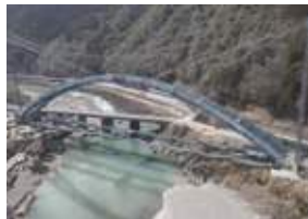
鎌瀬橋の架設状況
