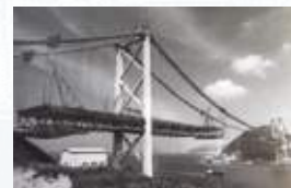
架設中の関門橋
