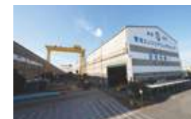
宮地エンジニアリング(株)千葉工場
