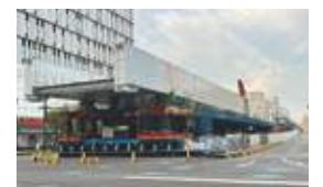
広電広島駅高架化関連工事
