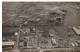
砂町第1・第2工場
