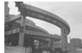
架設中の江戸橋ジャンクション
