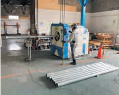
配管フレア加工
