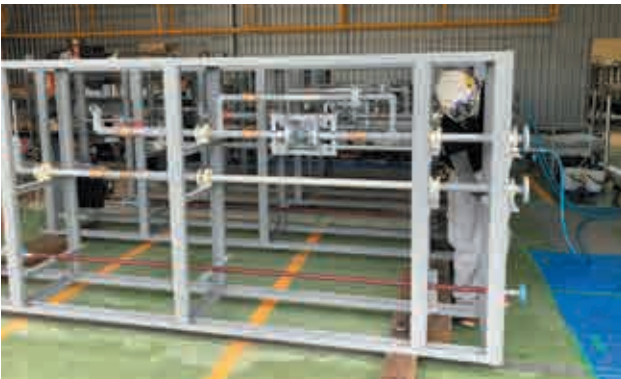
配管ユニット検査状況
