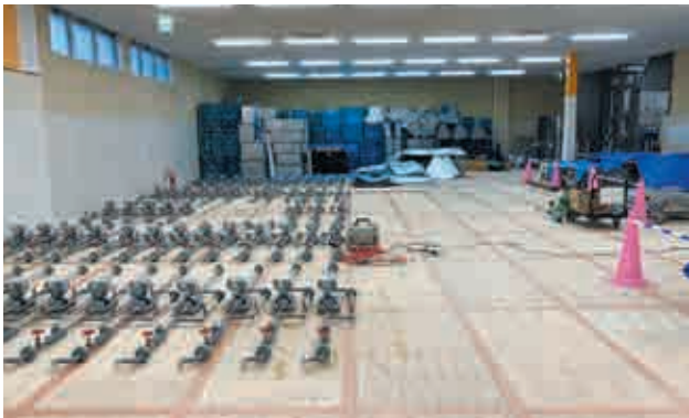
配管ユニット加工状況
