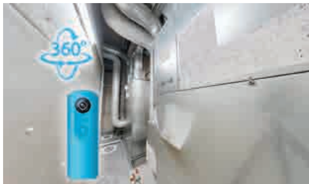
360度カメラによる現地の3次元記録
