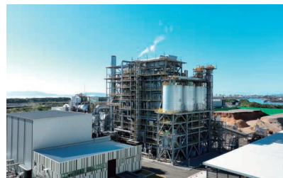
広畑バイオマス発電所（兵庫県）
